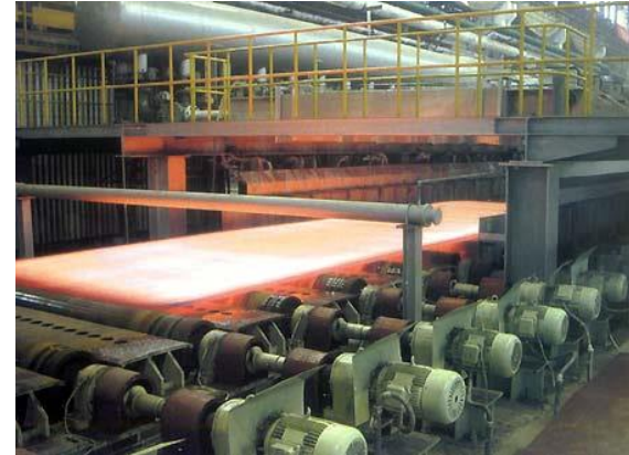
サイリスタ制御 圧延設備
